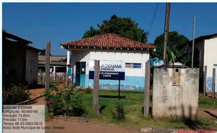
Sede da Roraima Energia em Cantá.
